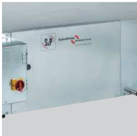
1 Acceso para la limpieza del intercambiador desde los paneles laterales.
